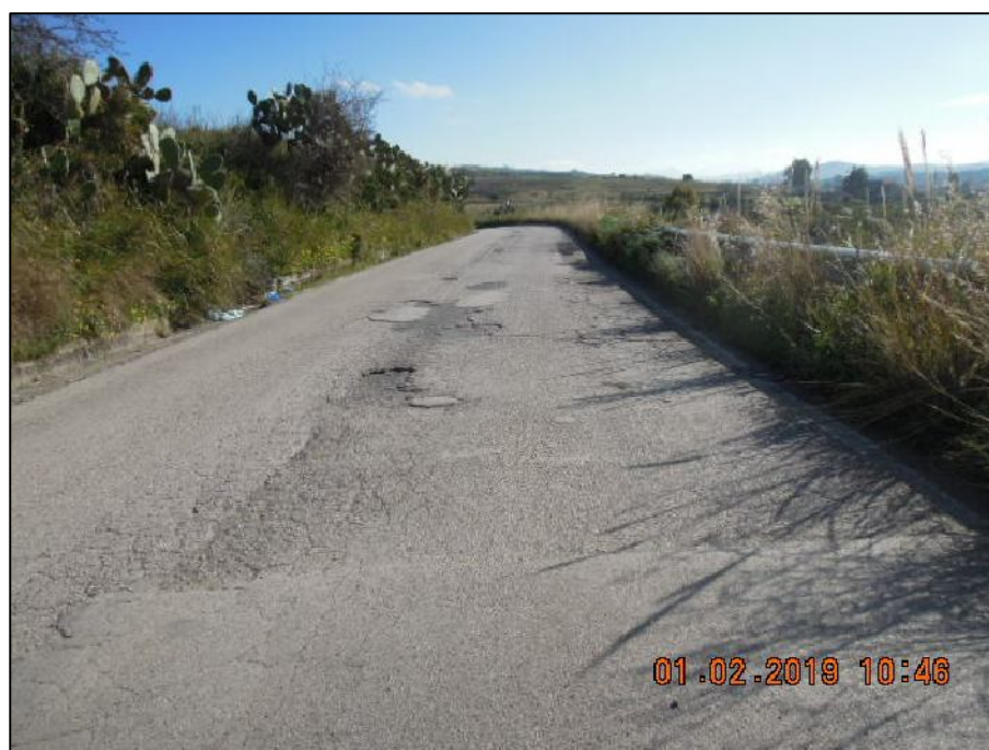
Stato di fatto alla progressiva chilometrica 0+550
