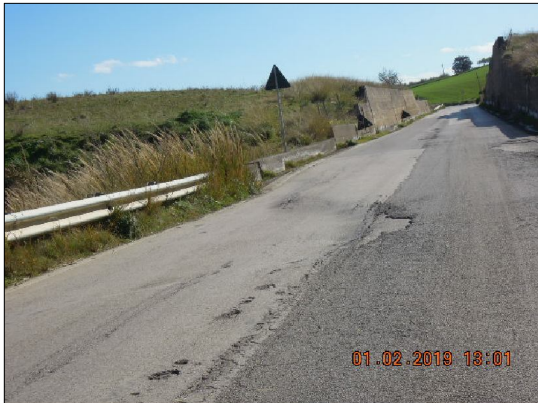
Stato di fatto alla progressiva chilometrica 3+550
