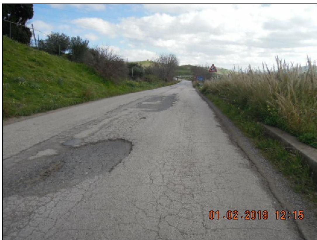
Stato di fatto alla progressiva chilometrica 1+850
