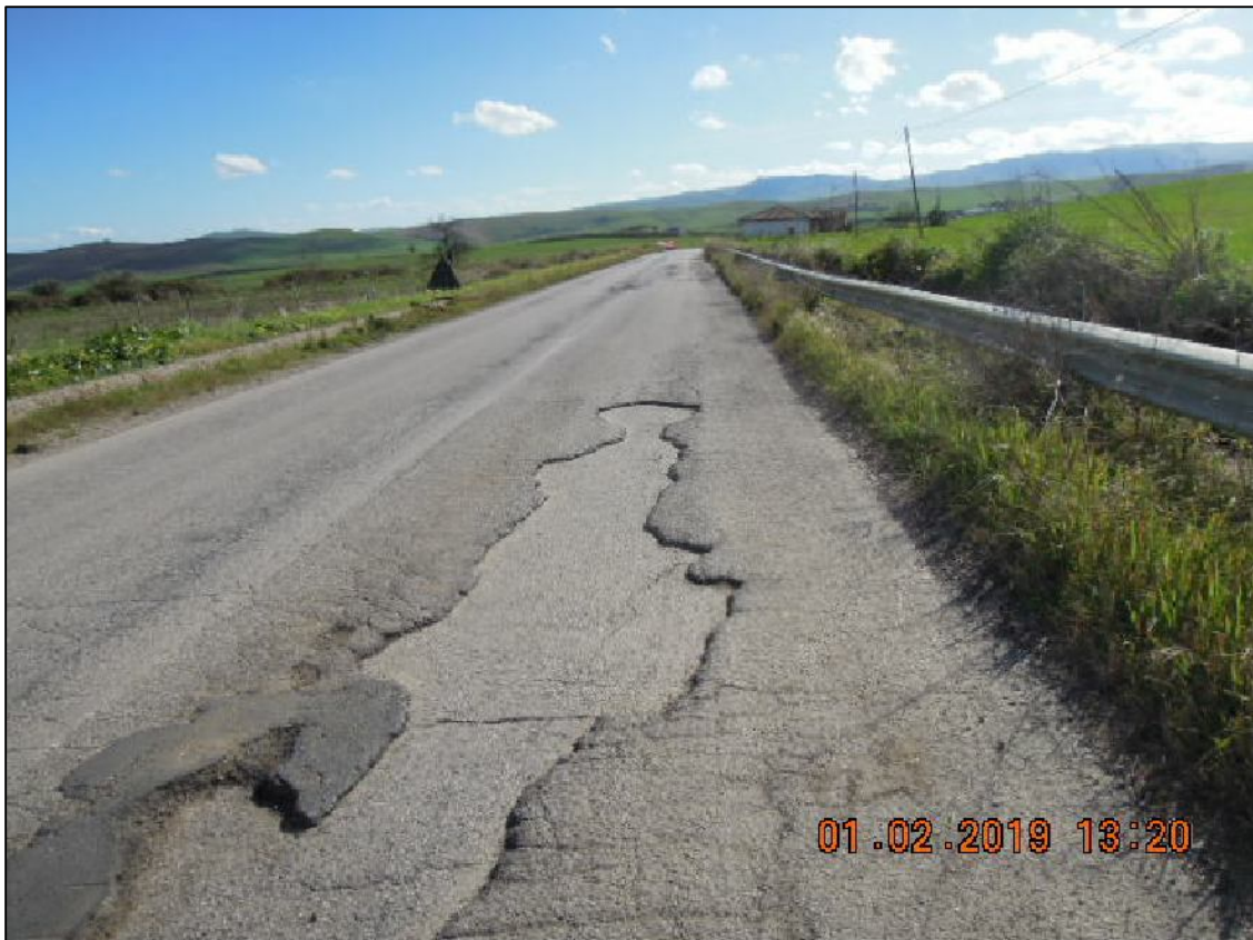
Stato di fatto alla progressiva chilometrica 4+200
