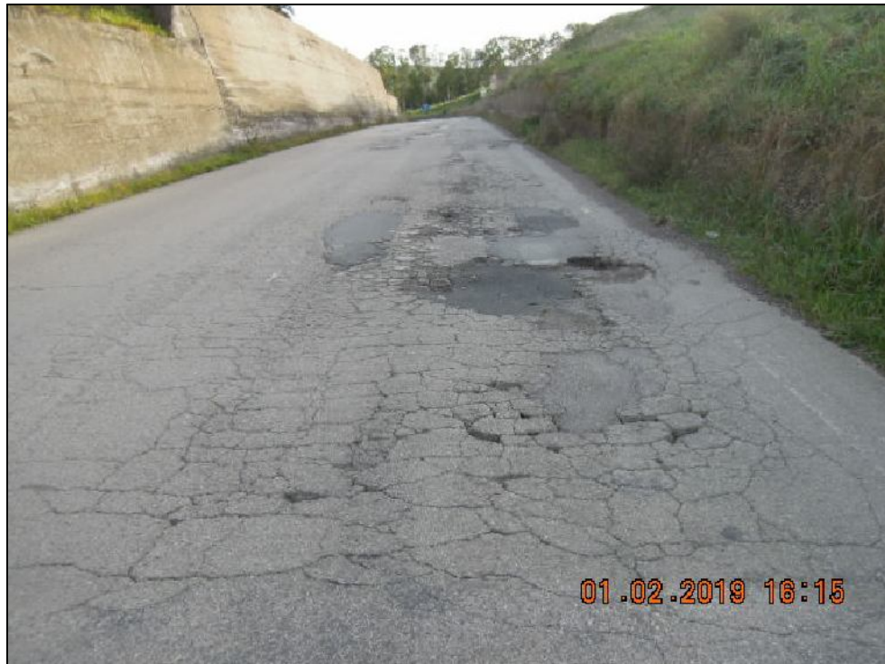
Stato di fatto alla progressiva chilometrica 5+900
