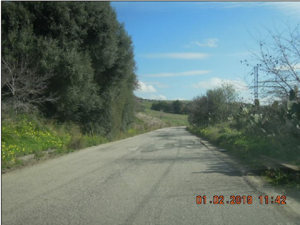
Stato di fatto alla progressiva chilometrica 1+300
