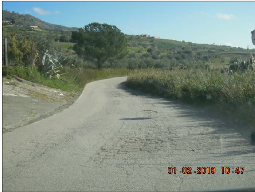
Stato di fatto alla progressiva chilometrica 0+550
