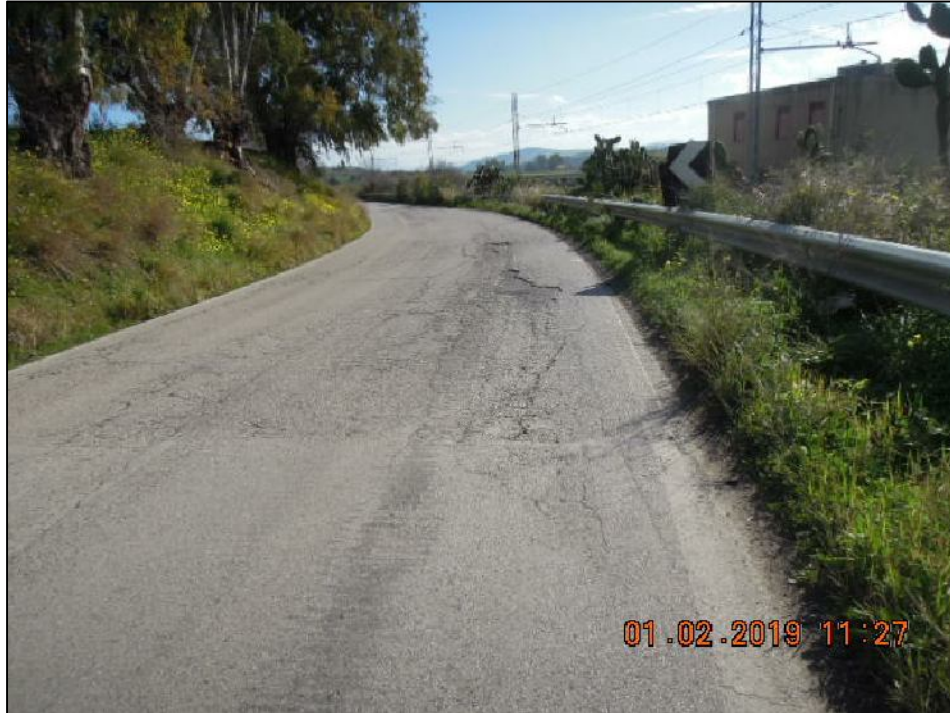
Stato di fatto alla progressiva chilometrica 1+100
