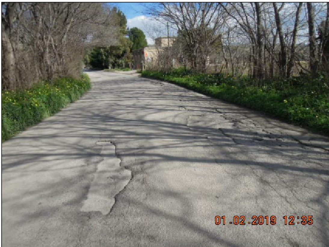
Stato di fatto alla progressiva chilometrica 2+700
