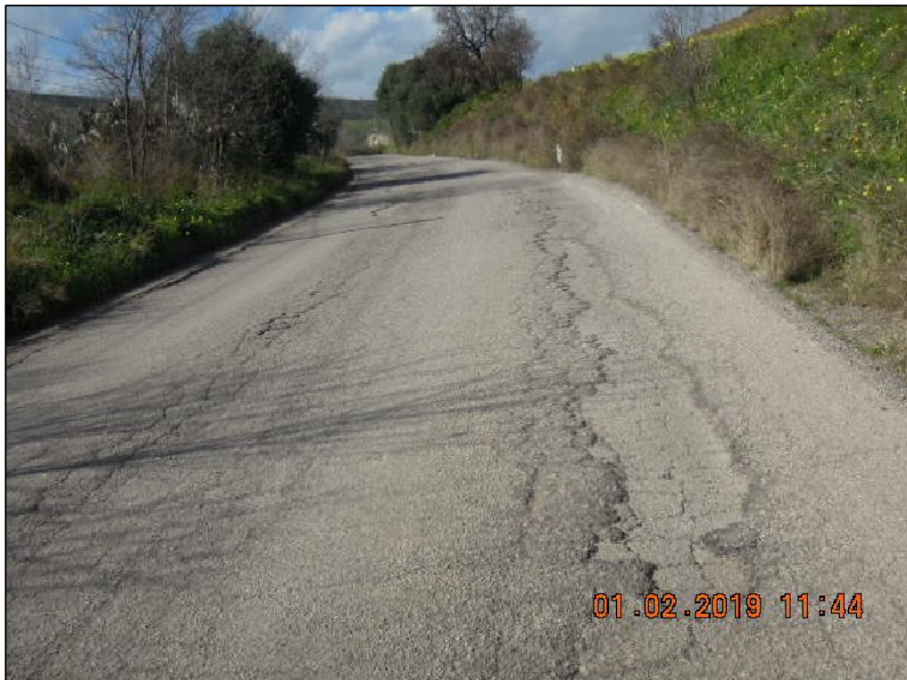
Stato di fatto alla progressiva chilometrica 1+300
