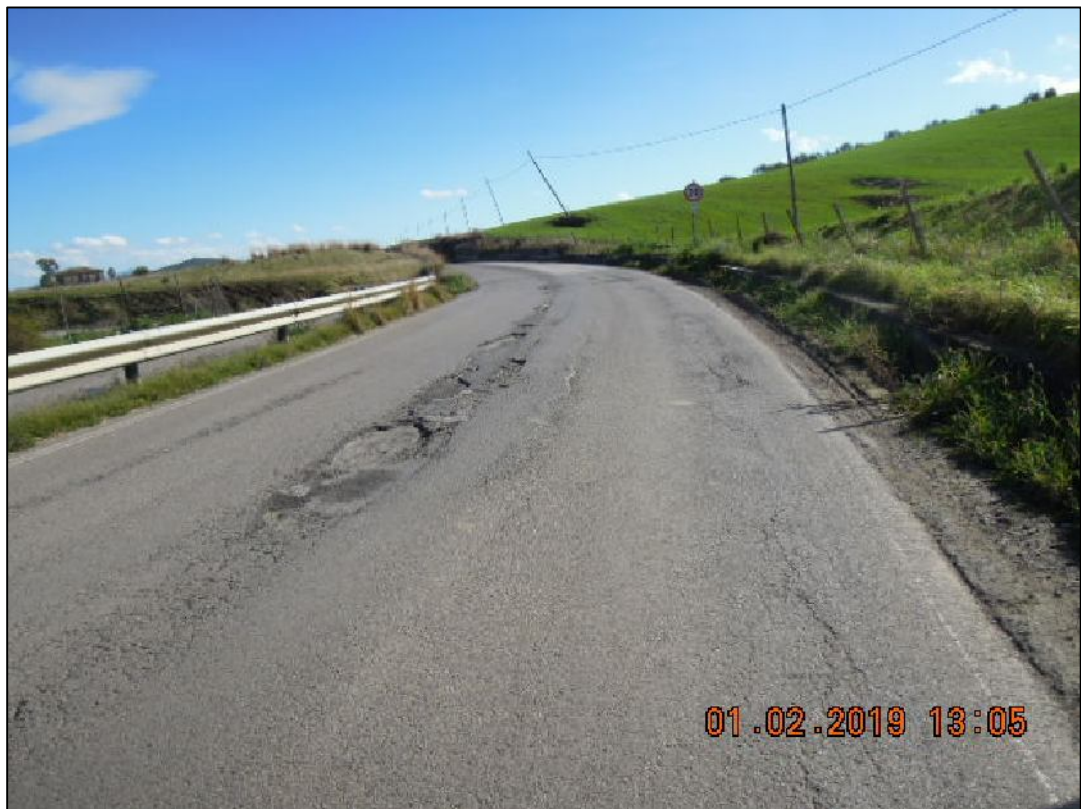
Stato di fatto alla progressiva chilometrica 3+750
