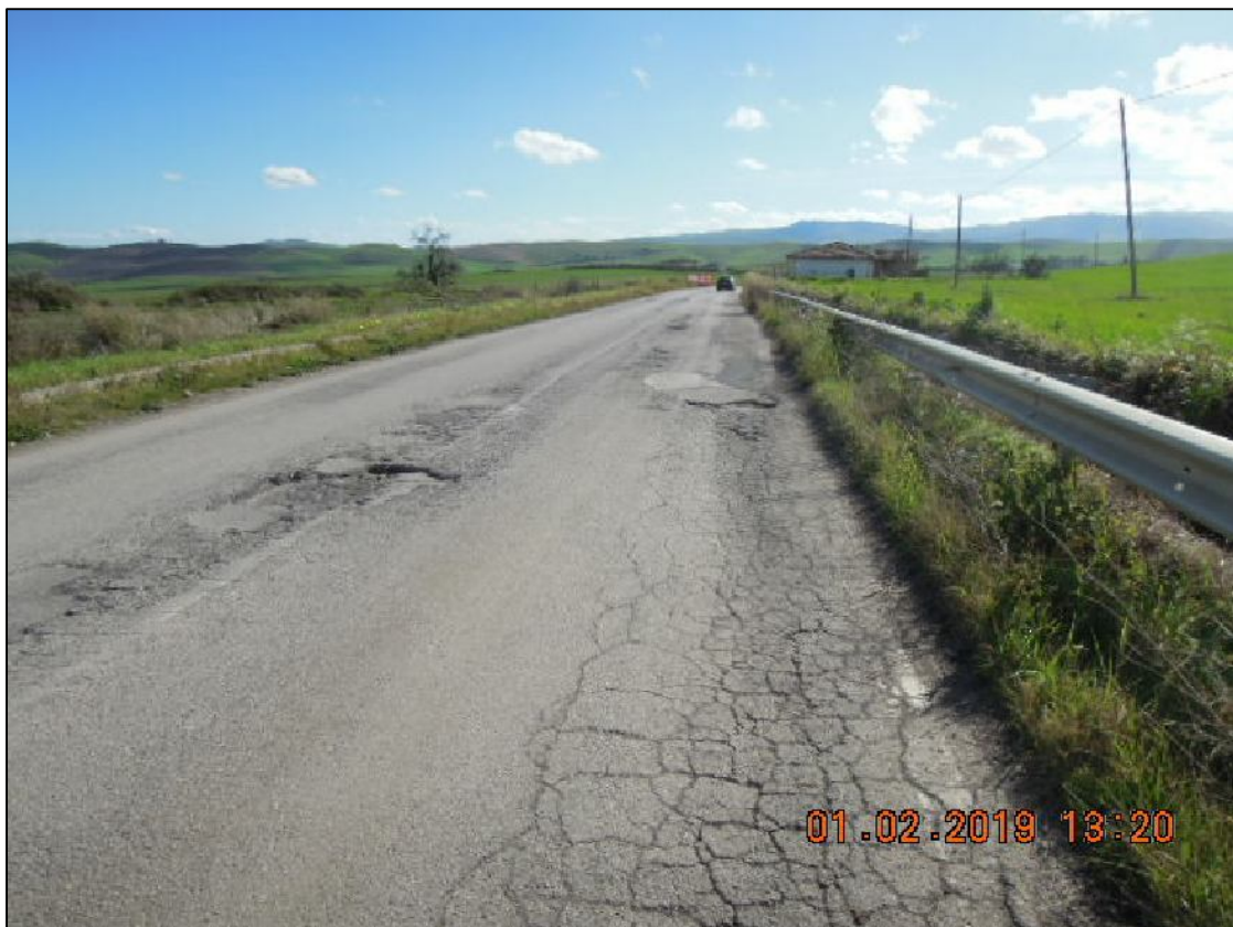
Stato di fatto alla progressiva chilometrica 4+200
