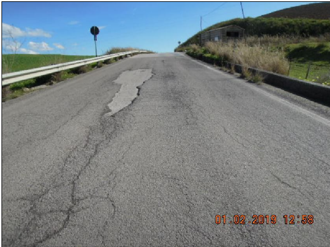
Stato di fatto alla progressiva chilometrica 3+350
