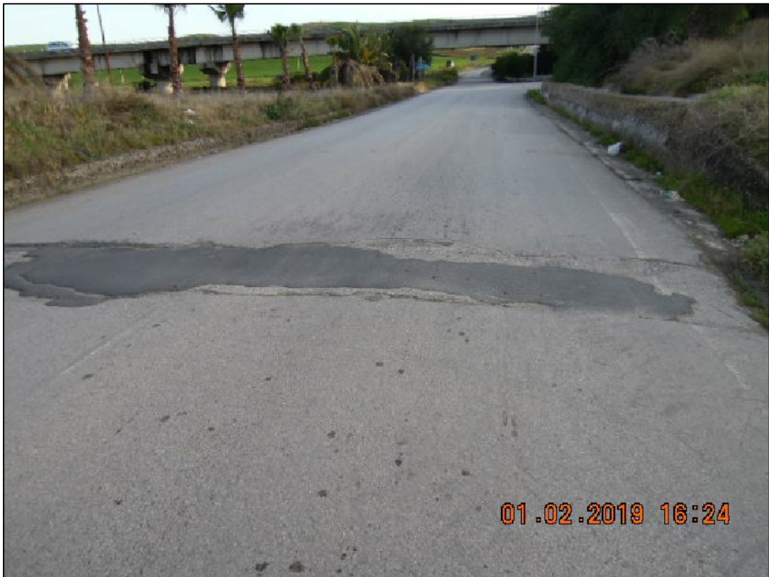
Stato di fatto alla progressiva chilometrica 6+050
