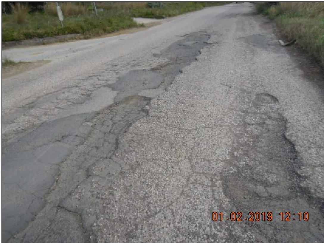
Stato di fatto alla progressiva chilometrica 1+850
