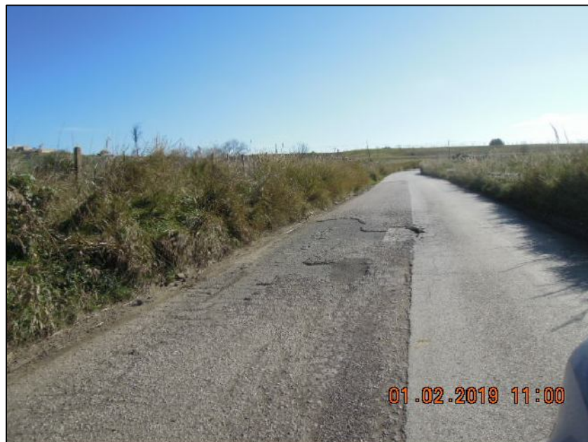
Stato di fatto alla progressiva chilometrica 0+750
