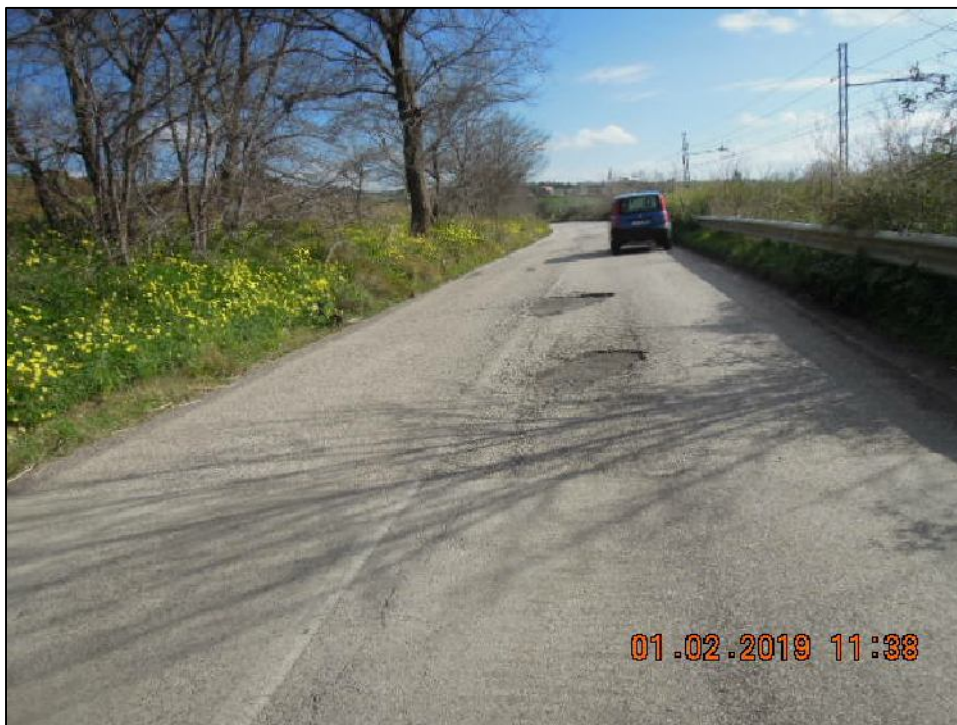
Stato di fatto alla progressiva chilometrica 1+100
