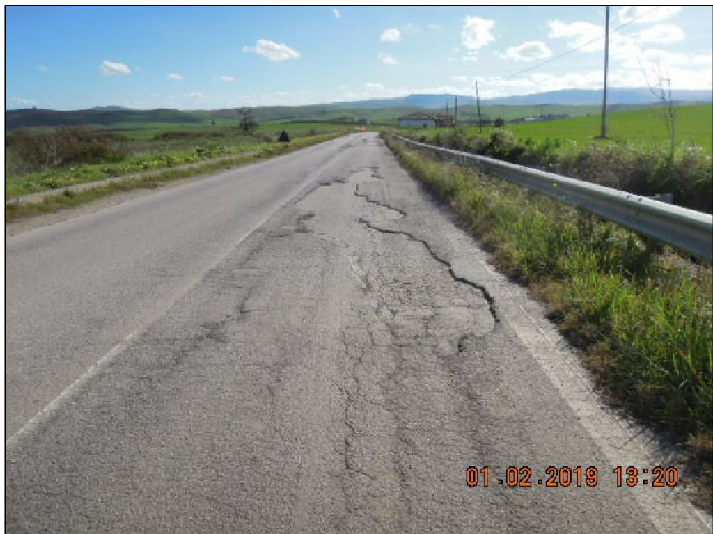
Stato di fatto alla progressiva chilometrica 4+200
