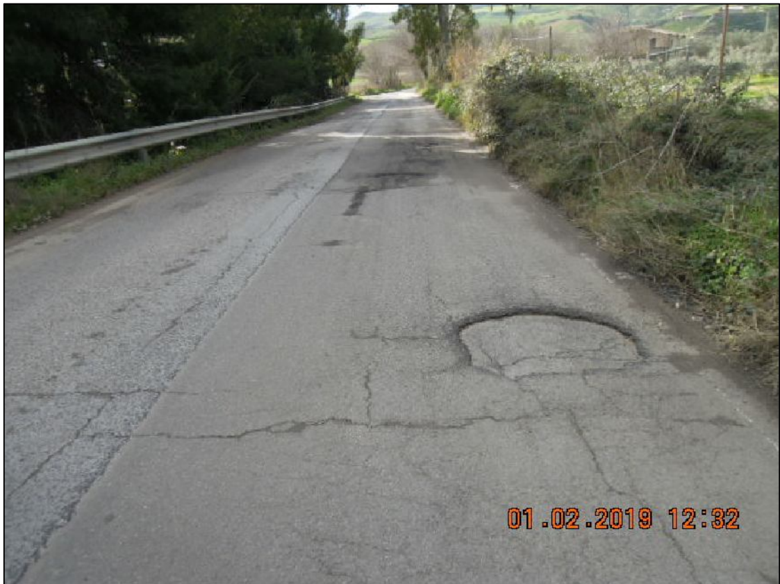
Stato di fatto alla progressiva chilometrica 2+700
