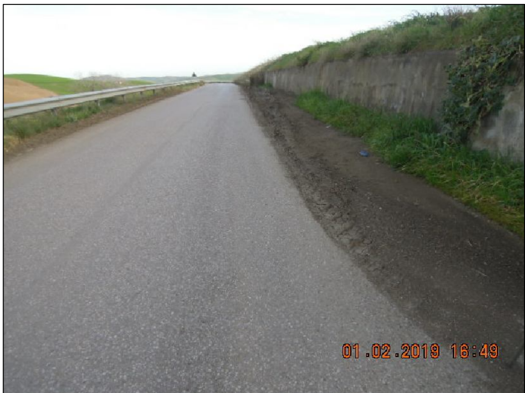
Presenza di detriti terrosi alla progressiva chilometrica 7+750 da rimuovere
