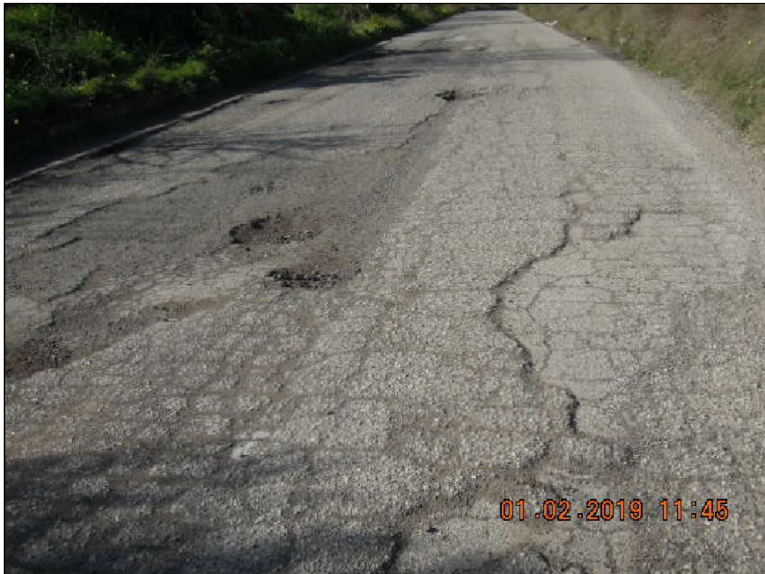
Stato di fatto alla progressiva chilometrica 1+650
