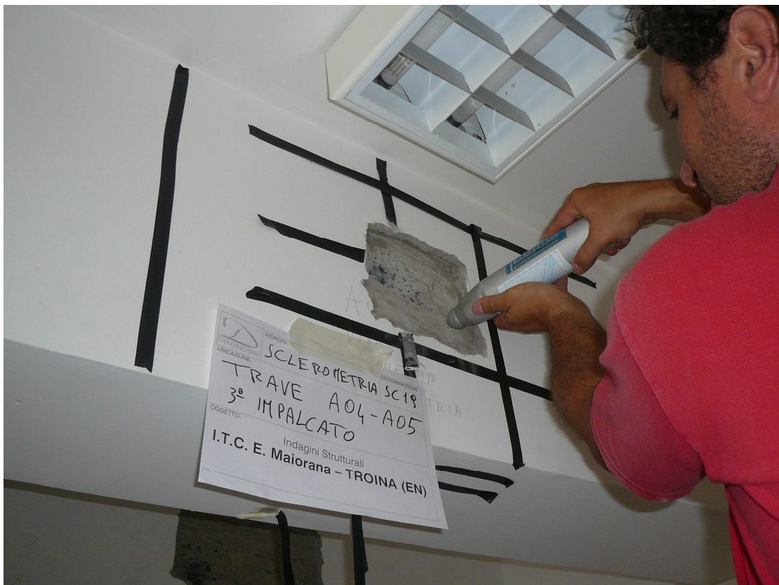
Figura 40 – Esecuzione prova sclerometrica
