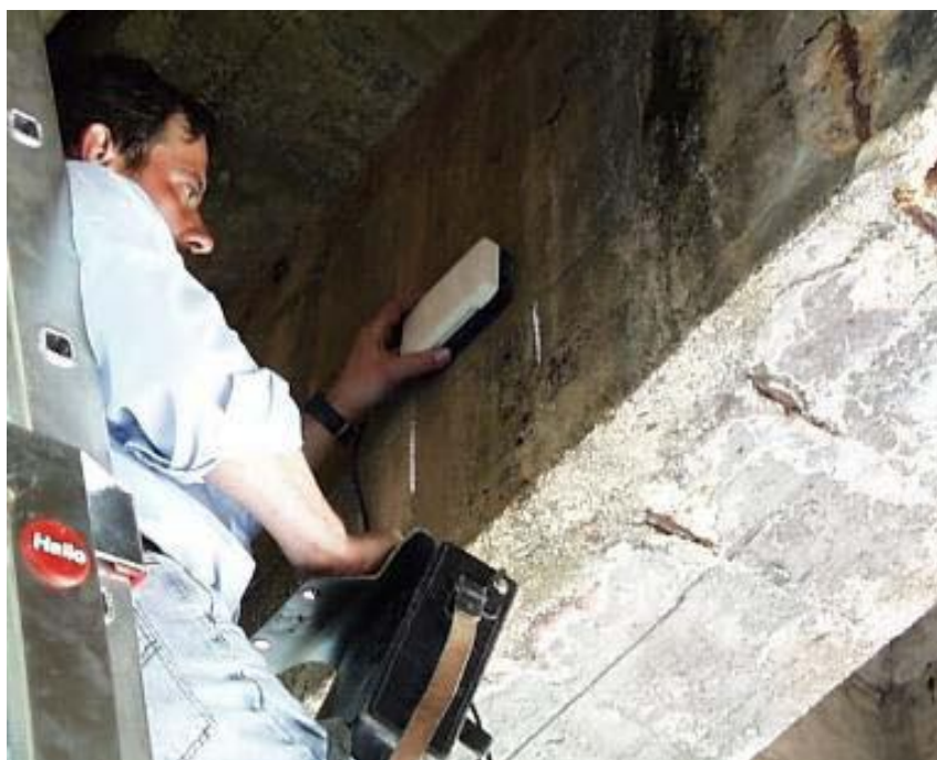
Figura 22 – Esecuzione prova pacometrica
