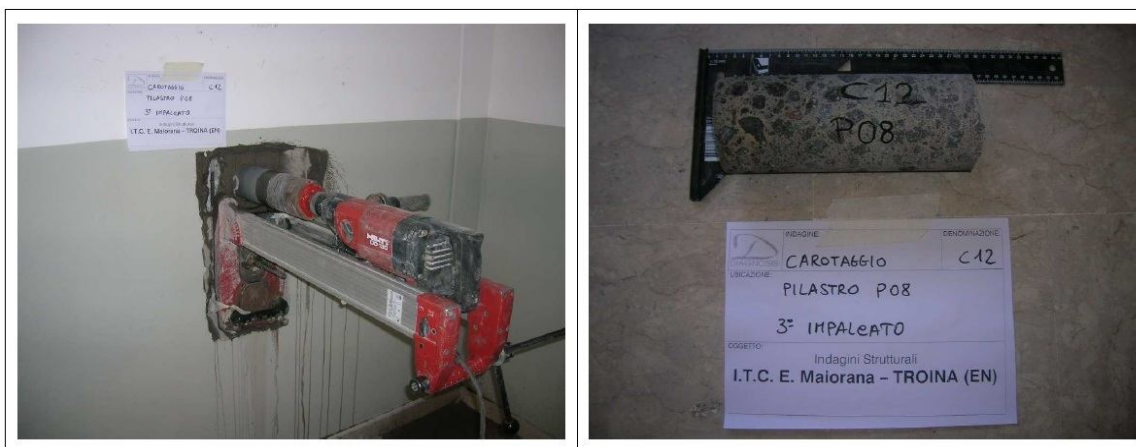
Figura 41 – Esecuzione carota C12
