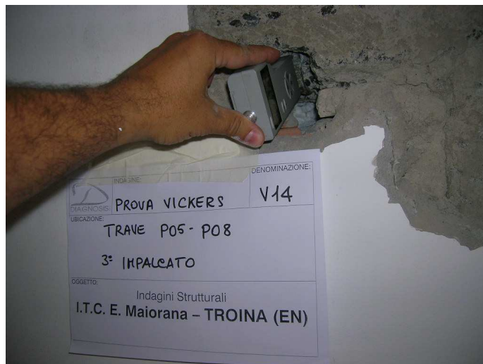
Figura 29 – Esecuzione prova Vickers
