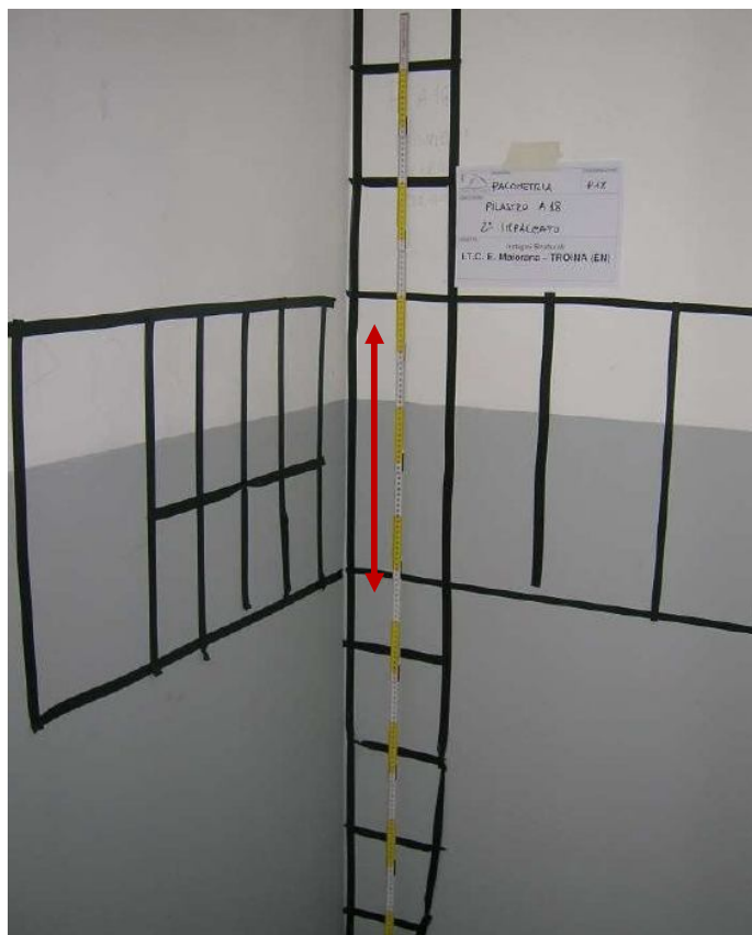
Figura 37 – Pacometria P18, assenza di staffe nel nodo
